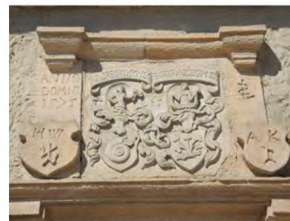
Ansicht der Wappentafel über der Türe
