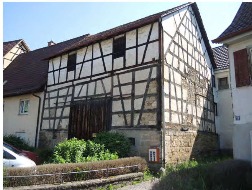
Ansicht der Scheune von Südwesten
