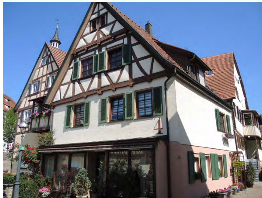
Ansicht des Wohn- und Geschäftshauses von Südosten
