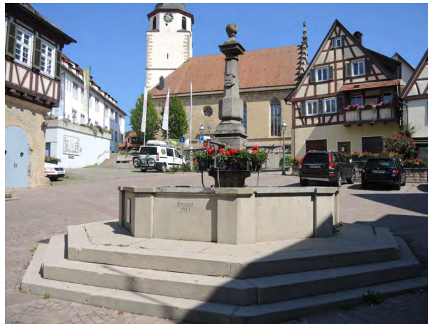
Ansicht des Marktbrunnens von Süden
