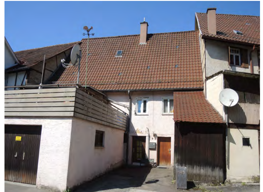
Ansicht des Wohnstallhauses von Nordosten
