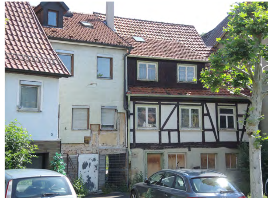
Ansicht des Wohnhauses (rechts im Bild) von Westen
