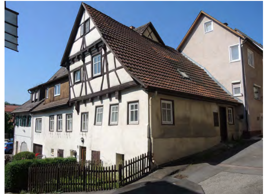
Ansicht des Wohnstallhauses von Nordosten
