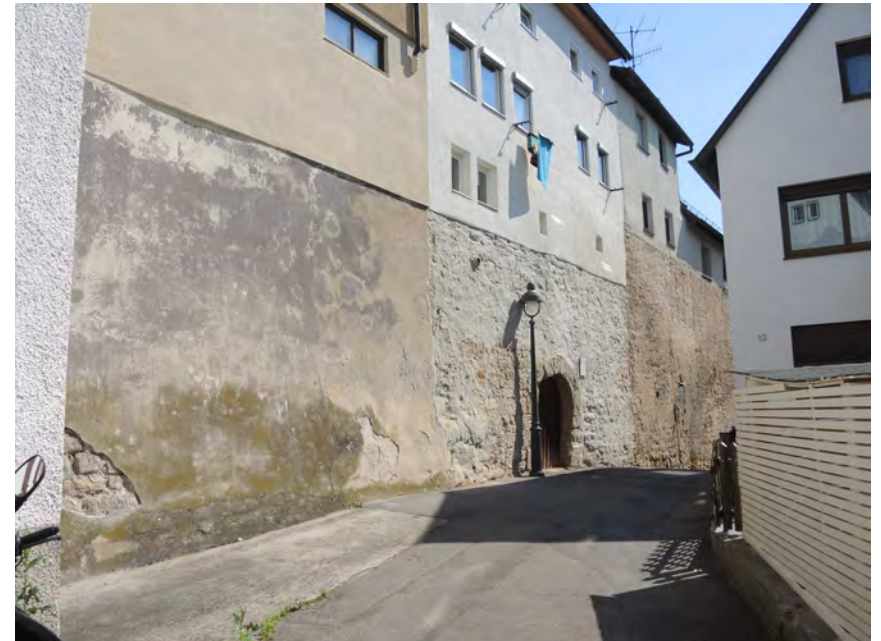
Ansicht der Stadtmauer auf der Südseite der Gebäude Marktstraße 24/1, 26 und 28.
