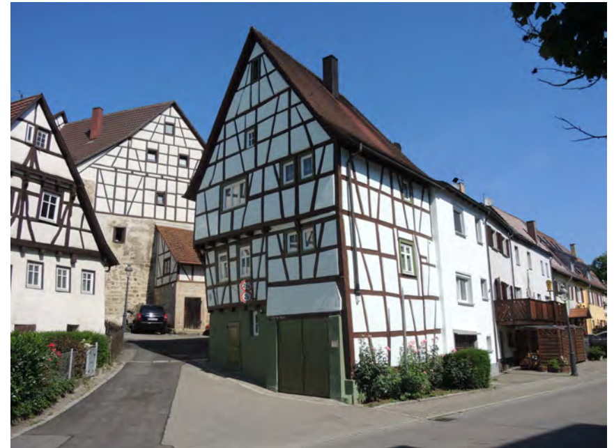
Ansicht des Wohnstallhauses von Südosten
