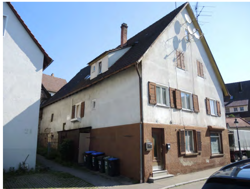
Ansicht des Wohnhauses von Südwesten
