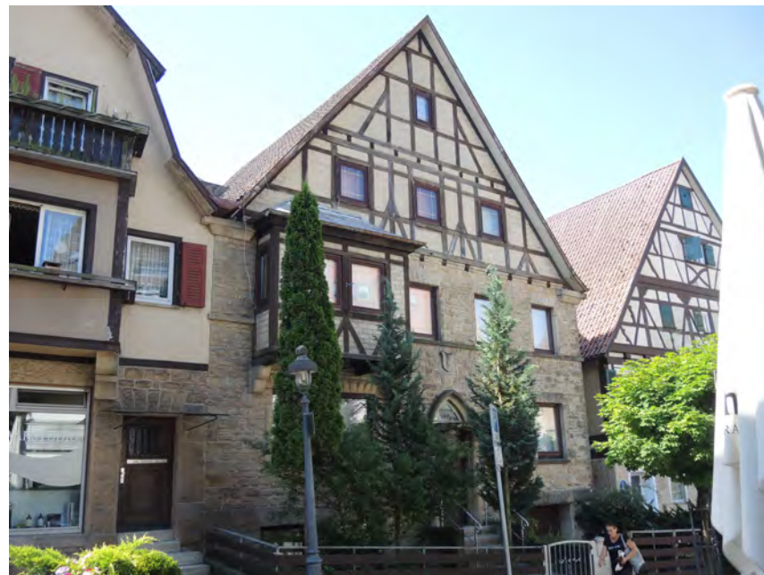
Ansicht des Wohnhaus von Nordosten
