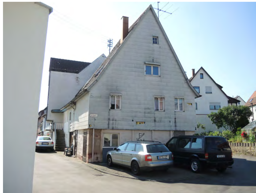
Ansicht des Wohnstallhauses von Nordwesten
