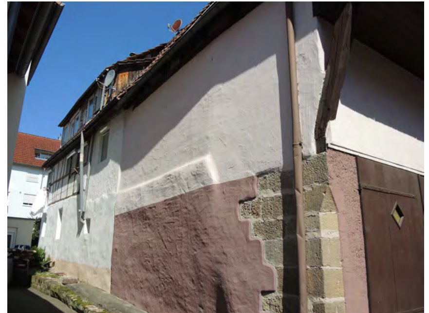
Ansicht des Wohnstallhauses von Südosten
