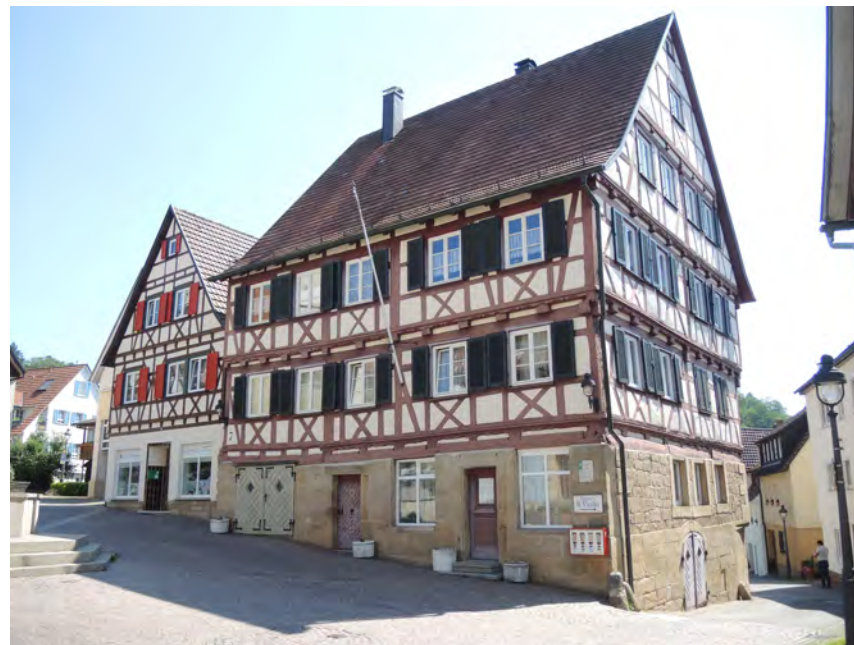
Ansicht des Wohnhauses von Südwesten
