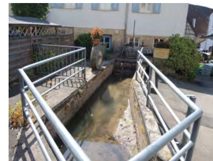
Ansicht des Mühlkanals an der Mühle
