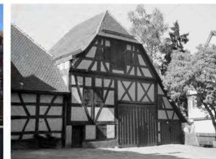
Historische Ansicht der Pfarrscheune 1958
