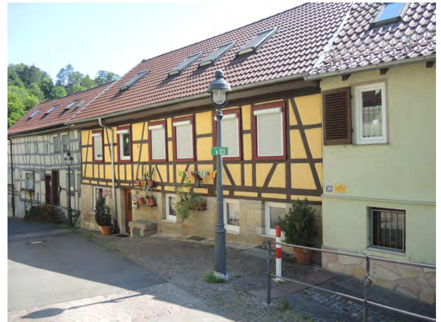
Ansicht des Wohnhauses von Südwesten
