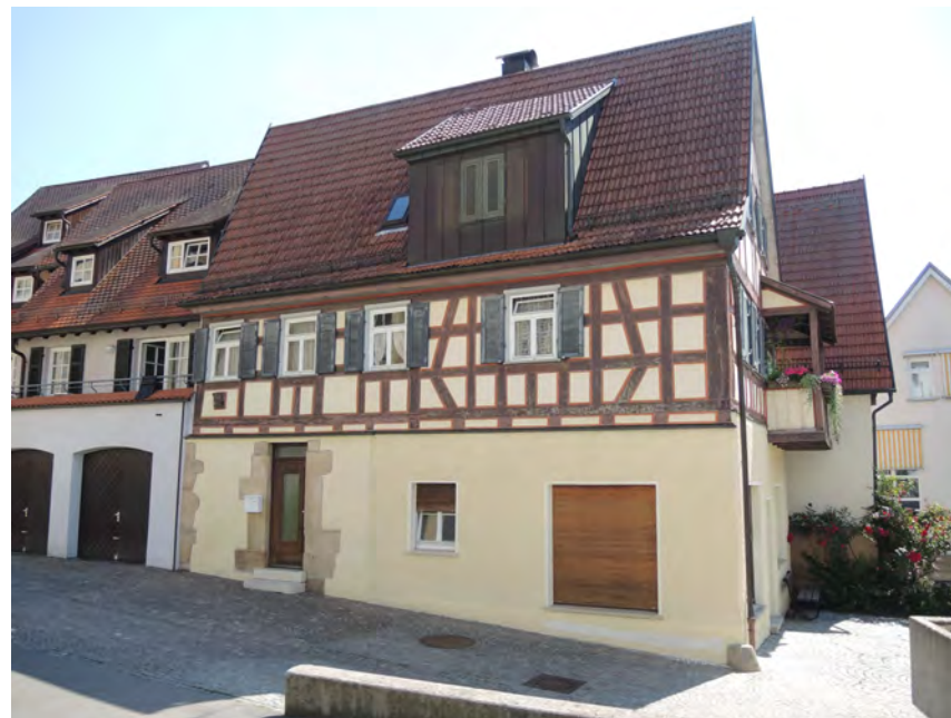
Ansicht des Wohn- und Geschäftshauses von Westen
