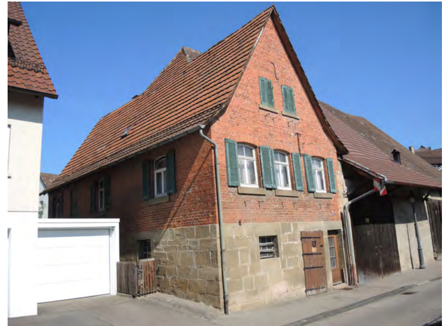
Ansicht des Wohnstallhauses von Südosten
