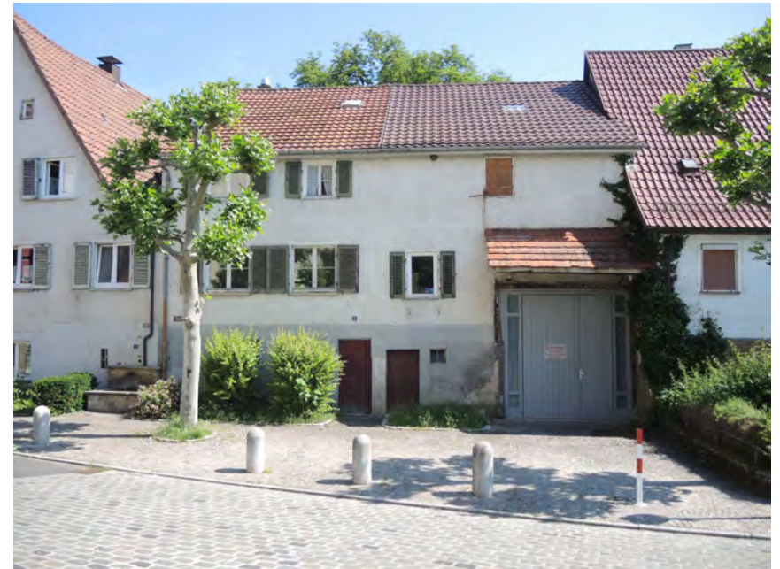
Ansicht des Wohnstallhauses von Südwesten
