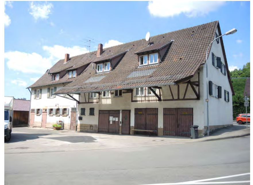
Ansicht des ehemaligen Farrenstalls von Osten
