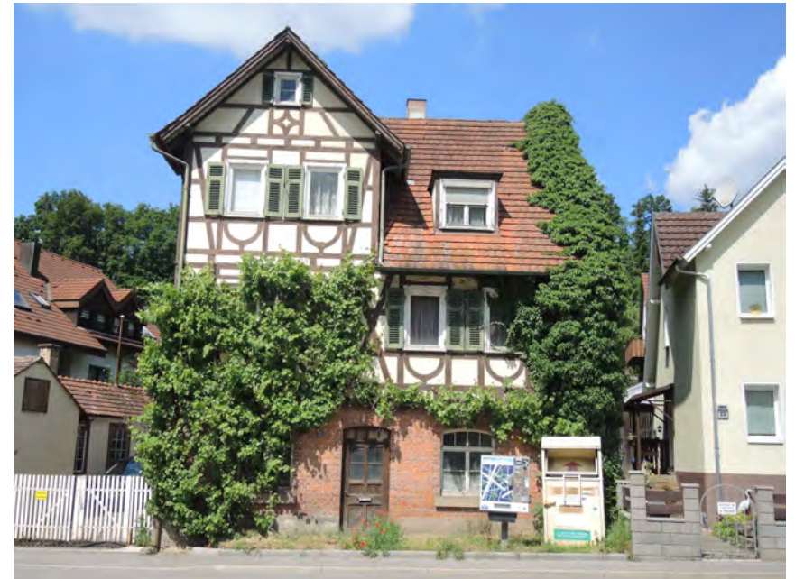
Ansicht des Wohnhauses von Osten
