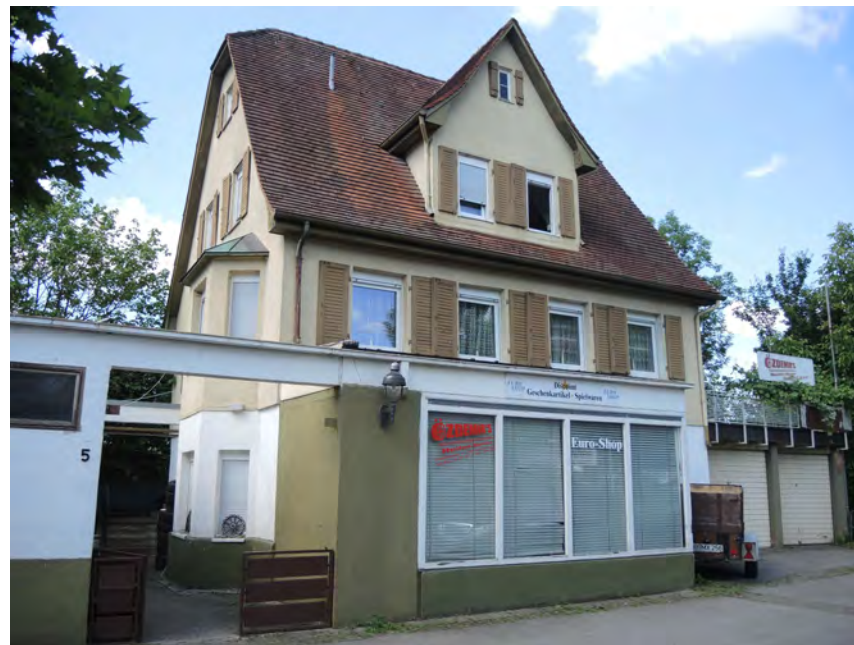
Ansicht des Wohnhauses von Nordosten
