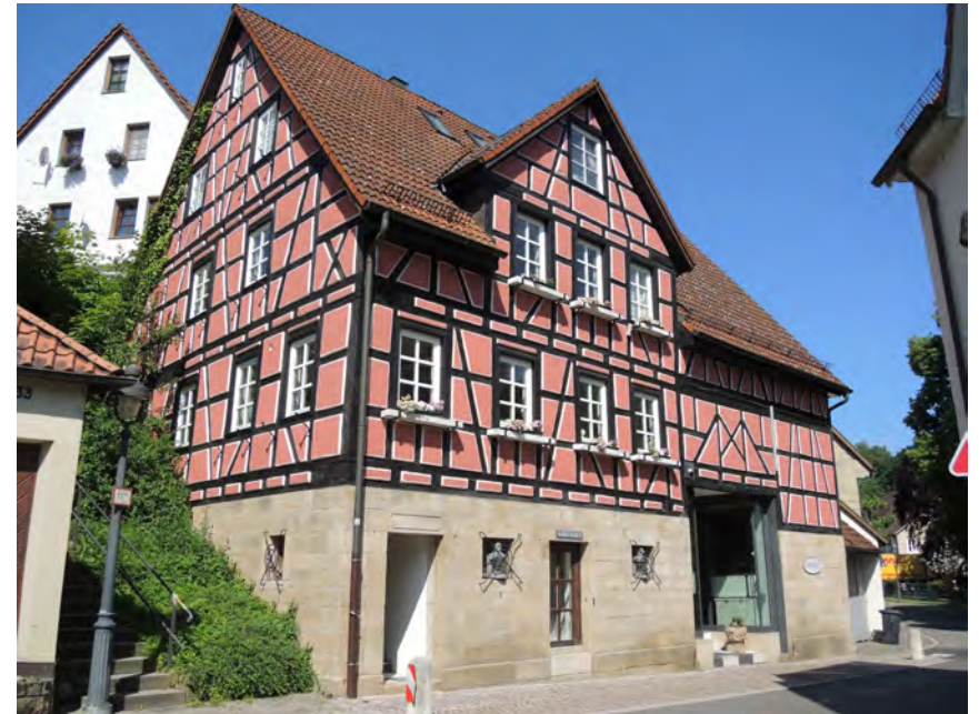
Ansicht des Wohnstallhauses von Südosten
