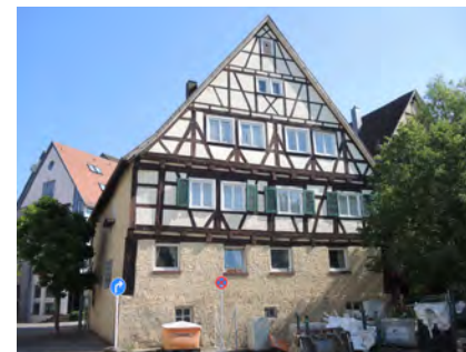
Ansicht des Hauses von Südwesten
