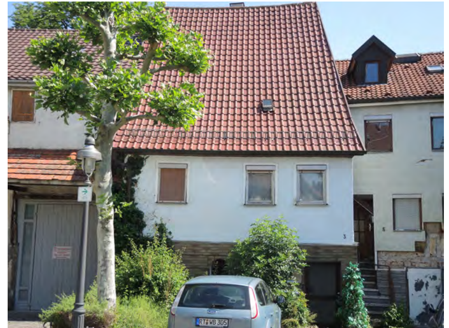
Ansicht des Wohnstallhauses von Südwesten
