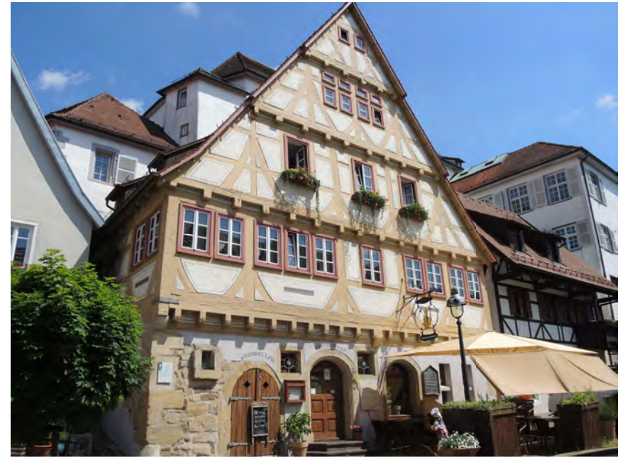
Ansicht des Wohnstallhauses von Südwesten
