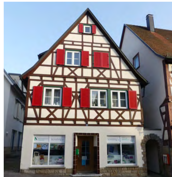
Ansicht des Wohn- und Geschäftshauses von Westen
