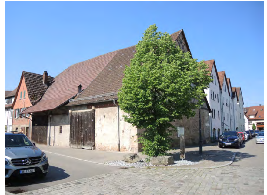
Ansicht der ehemaligen Zehntscheune von Nordosten
