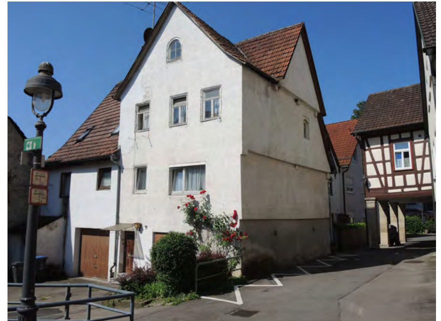
Ansicht des Wohnstallhauses von Südosten
