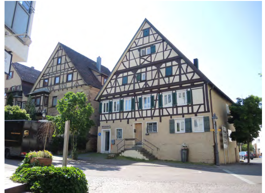
Ansicht des Wohnstallhauses von Nordwesten
