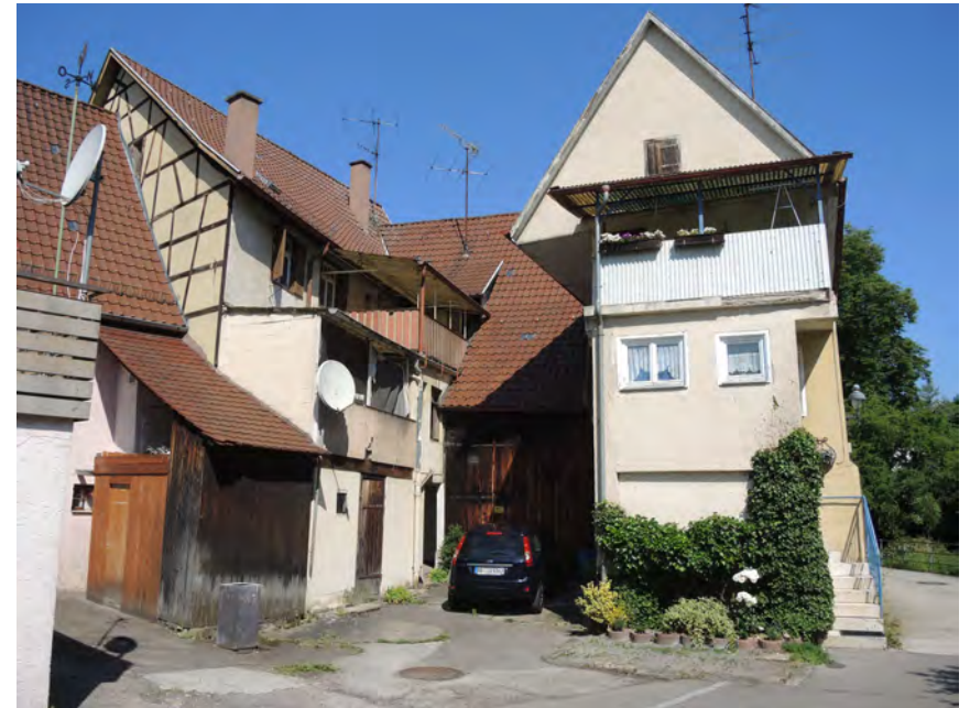
Ansicht der Hofanlage von Südosten
