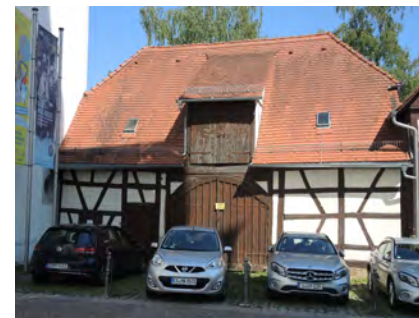
Ansicht der Schlossscheune von Süden
