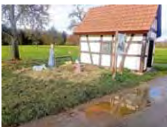
Krippe beim Feldschützenhäuschen
